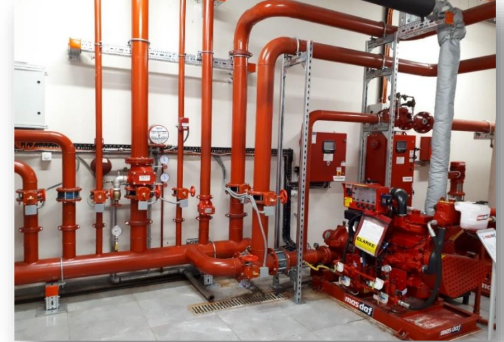
Yangın Pompa Dairesi
