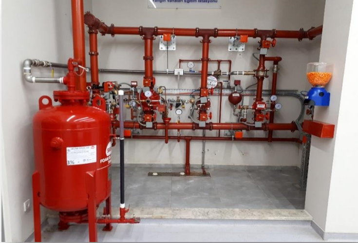
Alarm Vanası İstasyonu
