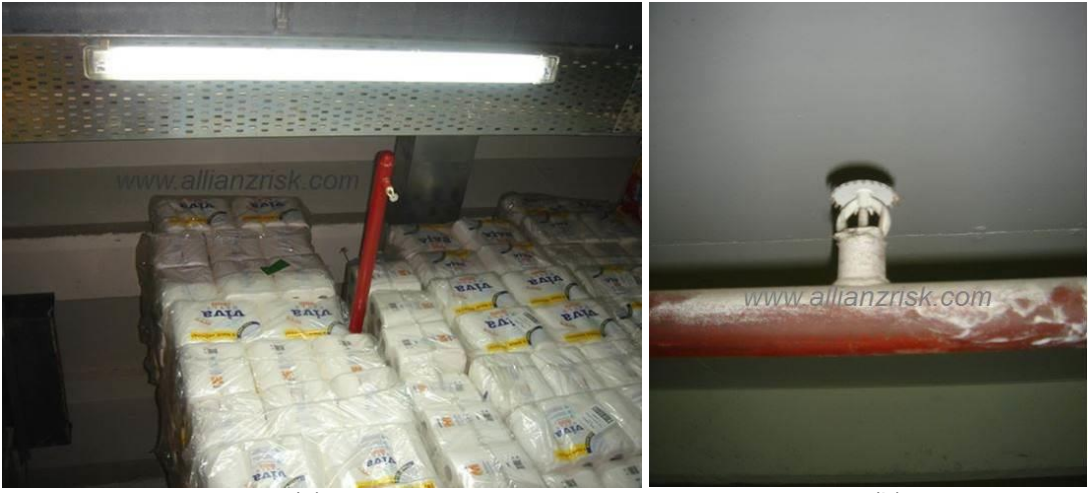
(a) (b) Resim 6: Sprinkler başlıklarının üzerine kadar çıkan istif yüksekliği (a); boya-badana sırasında boyanan sprinkler başlığı (b)
